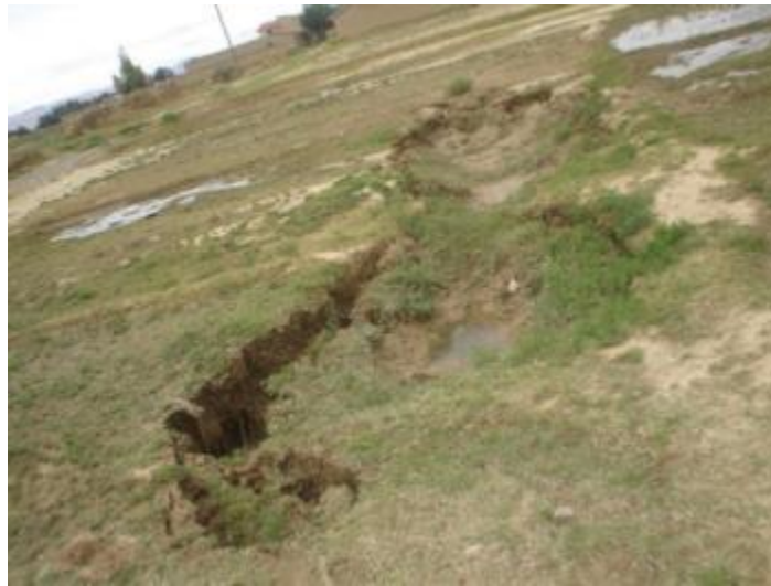
Figura 14. Hundimiento de suelo
