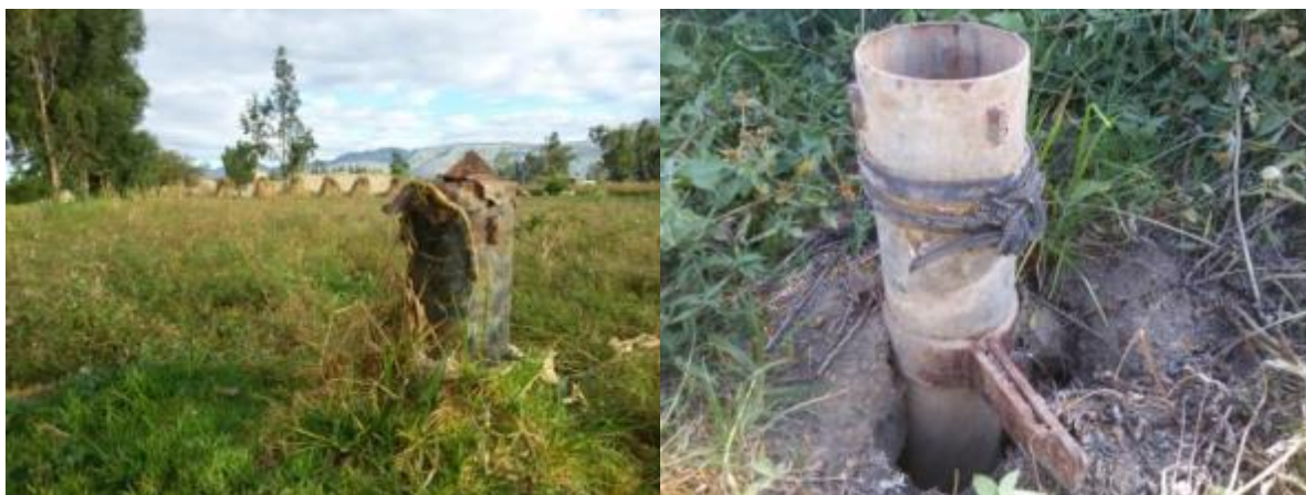
Figura 7. Fotografías de pozos que han dejado de funcionar
