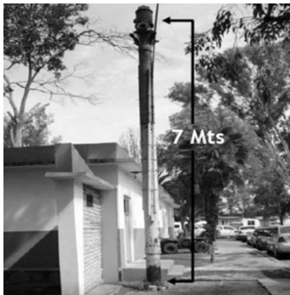
Figura 16. Asentamiento de tierra en el pozo San Juan de Aragón, México (1936-2005)
